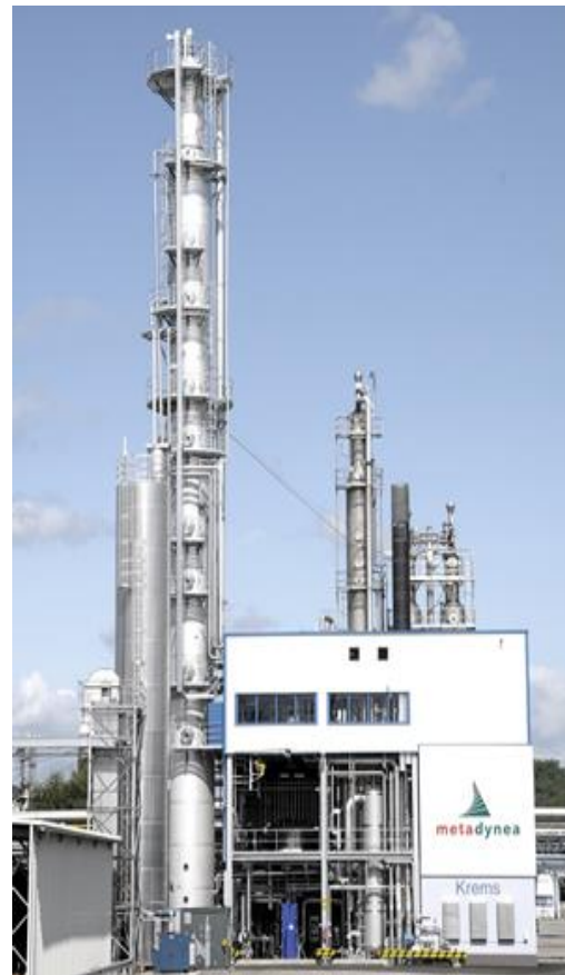
Bild 3: Eine der Produktionsanlagen von Metadynea Austria GmbH am Standort in Krems.
